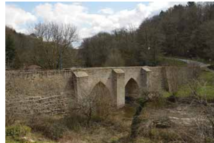
Photographie 26 : Pont de Châteauponsac (MH n°60)
