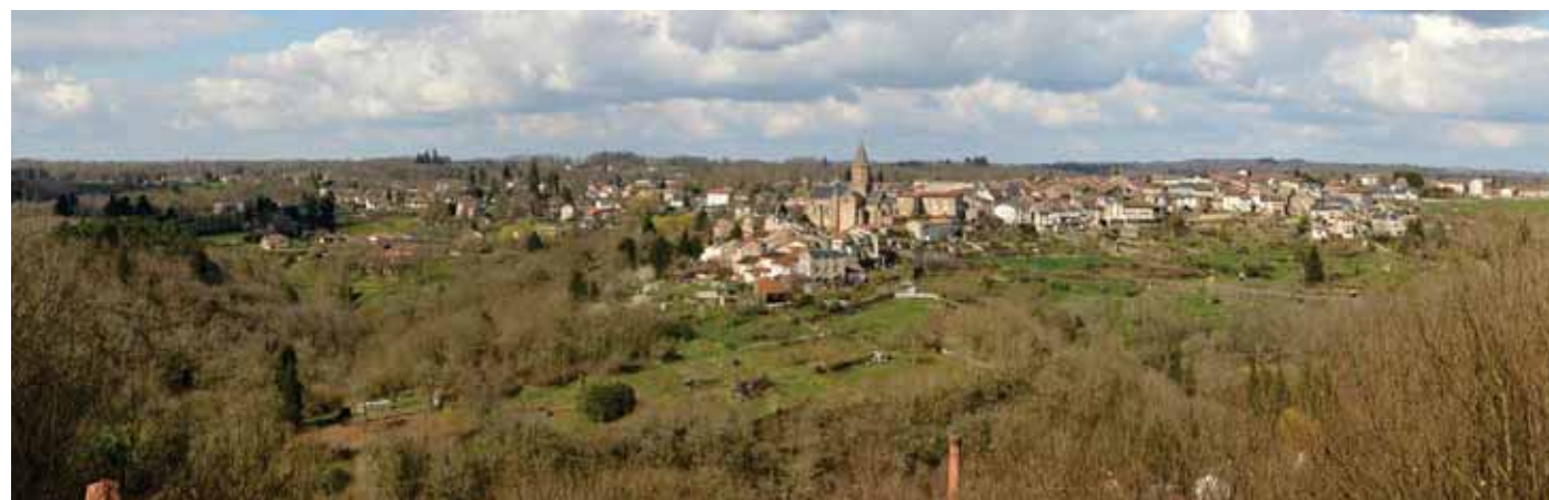
Photographie 29 : Châteauponsac et vallée de la Gartempe
