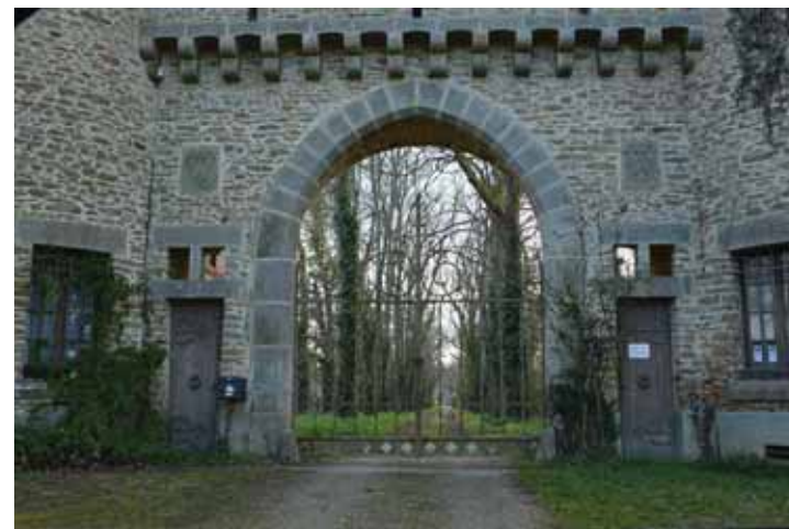
Photographie 79 : Entrée du domaine de Lascroux (MH n°4)
