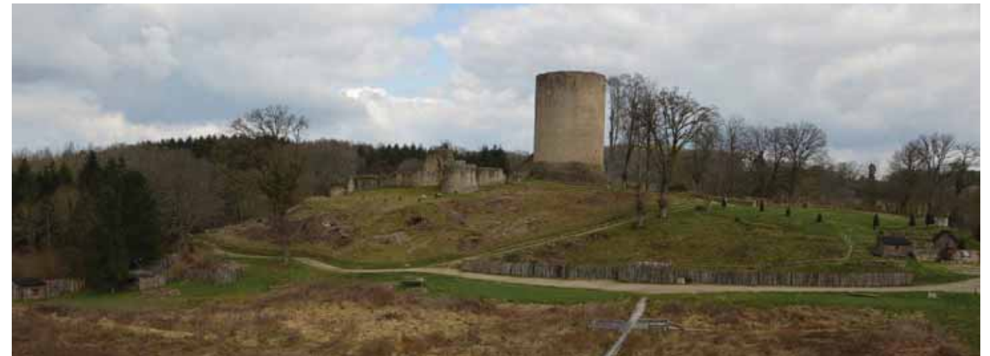
Photographie 28 : Tour et vestiges de Bridiers (MH n°55)
