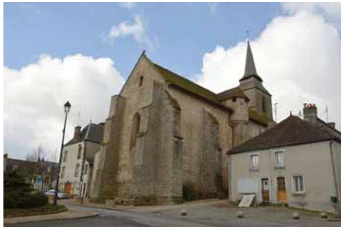
Photographie 53 : Eglise d'Arnac-la-Poste (MH n°9)
